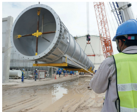
Einsatz der Tracker beim Transport einer Gasturbine
